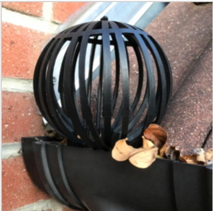
● Laisse l'eau s'écouler et piège les débris.
